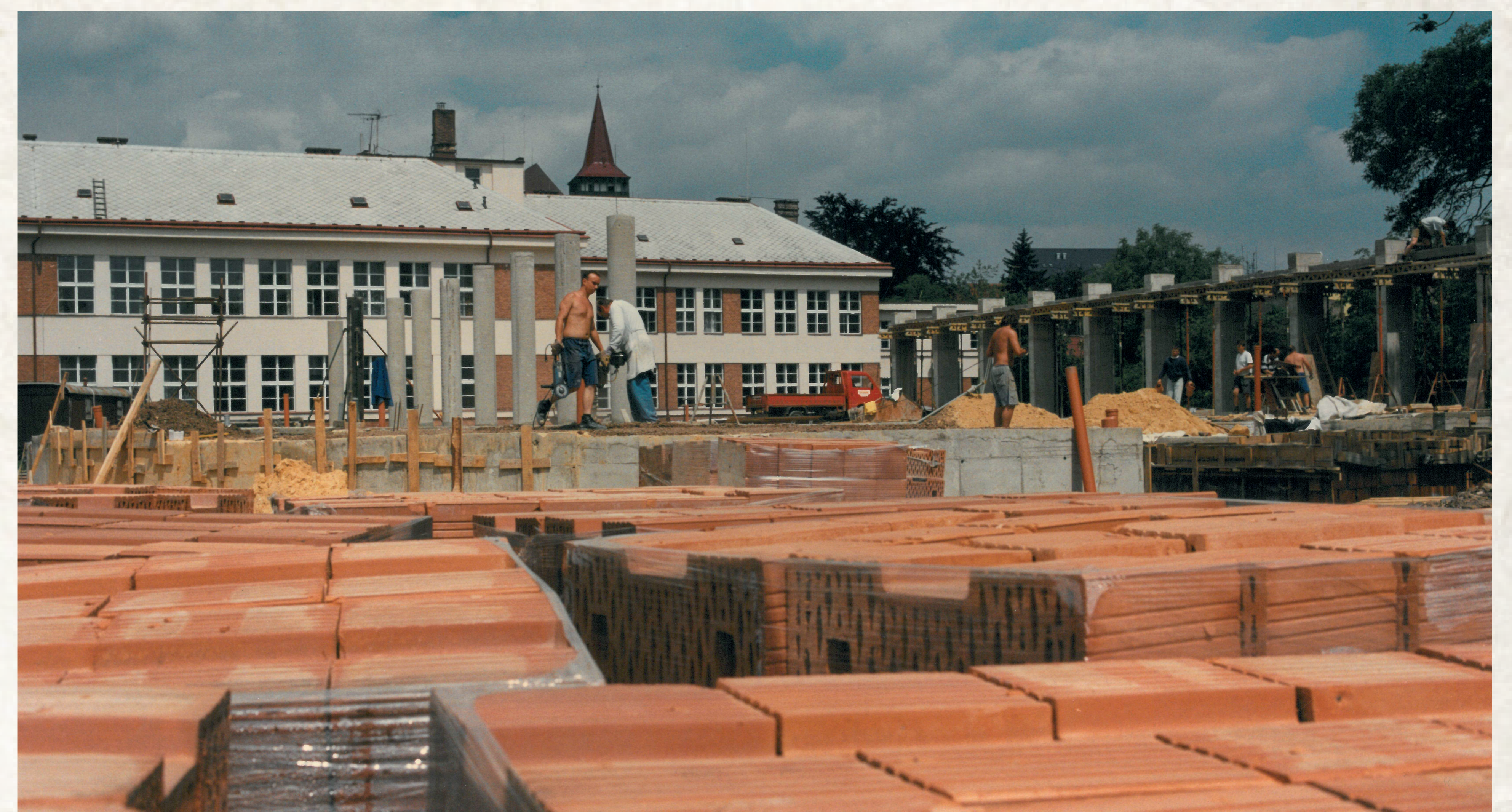
Práce na přístavbě (Sbírka MOA)
